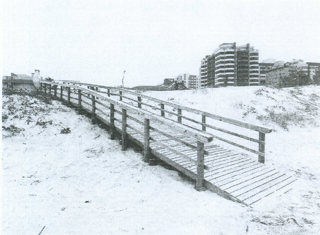
FOTO DEPOIS DE SER CONCLUIDA.
